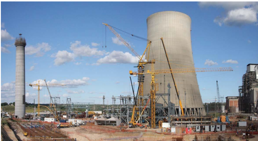
中国国华国际工程承包公司承建-巴西坎迪奥塔火电厂项目全景
