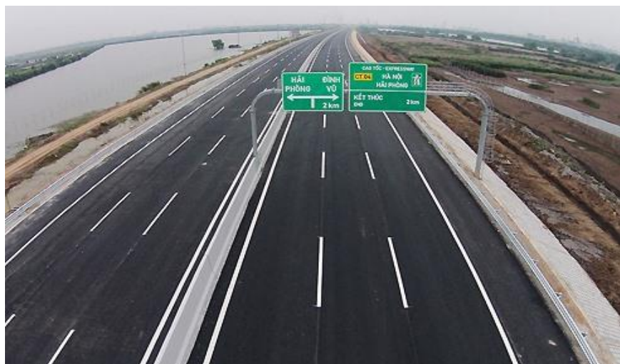
河内-海防高速公路
